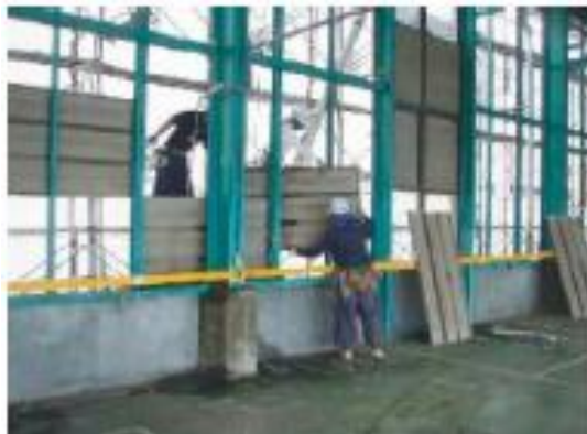
原形のまま取り外す作業
