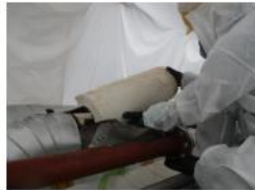
隔離養生内での作業
