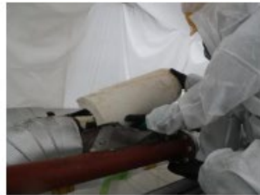
隔離養生内での作業
