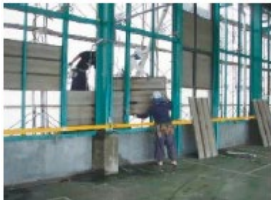
原形のまま取り外す作業
