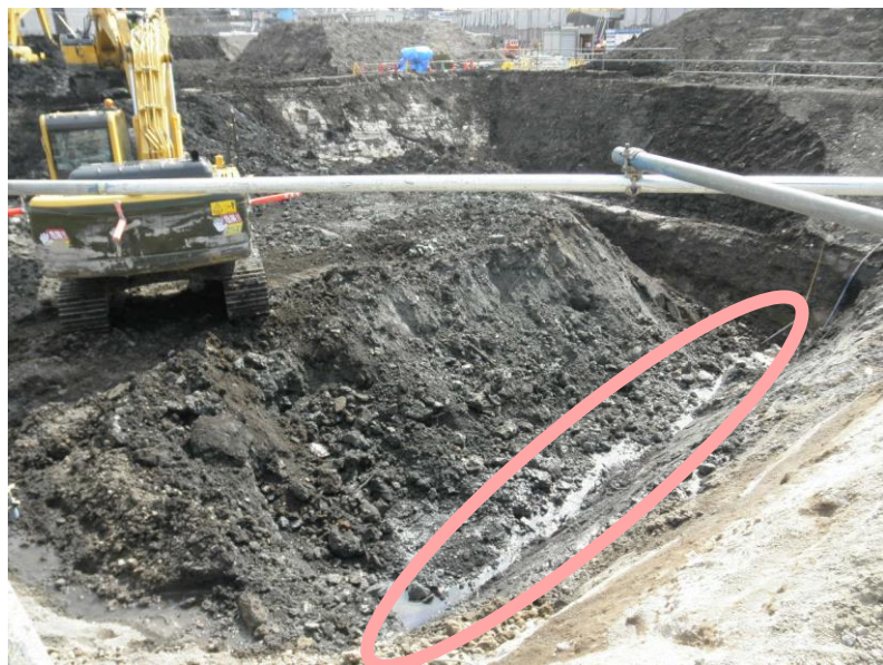
掘削などによる湧水
