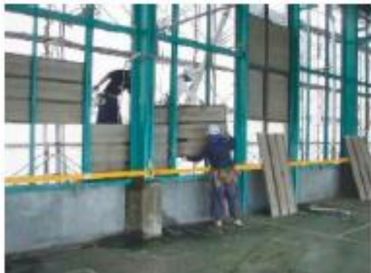
原形のまま取り外す作業
