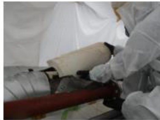
隔離養生内での作業
